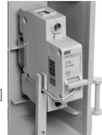
Фото 4. Механизм взвода автоматического выключателя
