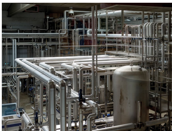
Обвязка технологических линий – проволочный лоток INOX (AISI 304)
