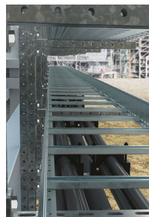
Подвод сил к перерабатывающ...
