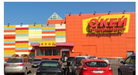
ТРЦ «ОКЕЙ», г. Красноярск
