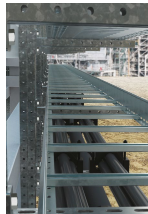
Прокладка высоконапряженных трасс на пролетах
