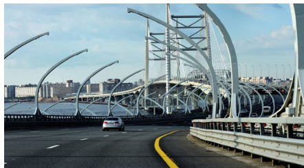
Строительство Западного скоростного диаметра в г. Санкт-Петербурге
