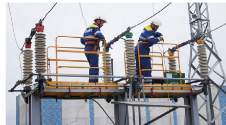
Реконструкция электрических сетей «Донэнерго»
