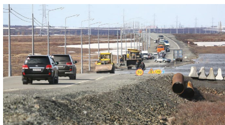
Обустройство автодороги Норильск-Оганер
