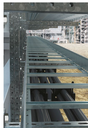
Прокладка высокопрофильных кабельных трасс на промышленных объектах
