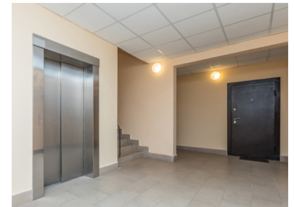
Этажный холл: светодиодные светильники ДПО 2000
