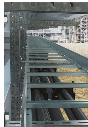
Прокладка высоконап трасс на пролет
