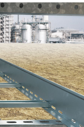
Горизонтальная прокладка кабелей в лотках до 6 метров
