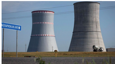
Атомная станция в г. Островец (Беларусь)
