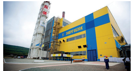
Южно-Сахалинская ТЭЦ-1, ОАО «Сахалинэнерго»
