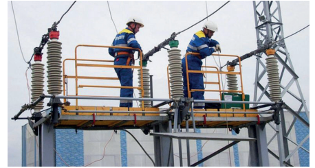
Реконструкция электрических сетей «Донэнерго»
