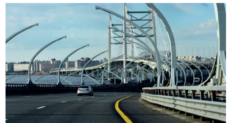
Строительство Западного скоростного диаметра, г. Санкт-Петербург
