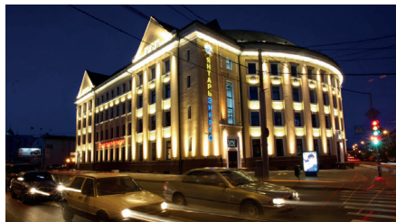
Реконструкция сетей учета ОАО «Янтарьэнерго» (Калининградская область)
